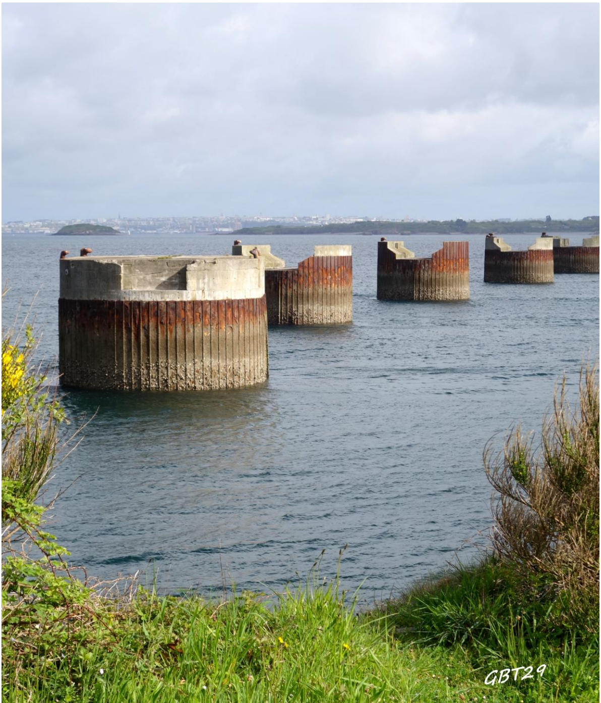
7/05/18 : vu du GR34 le 25 avril 2018: au premier plan, cinq des six gabions de palplanches de l'apportement pétrolier de Lanvéoc, au second plan, l'île Ronde, en arrière-plan, Brest la Blanche...
